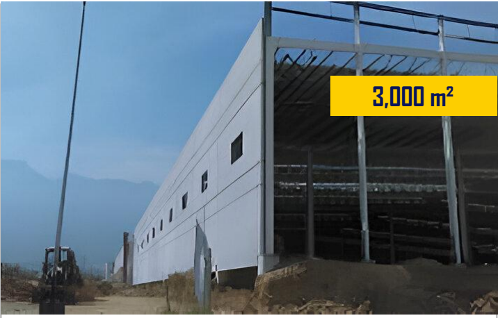
Nave mo-05 Muros prefabricados ▼ García N.L.
