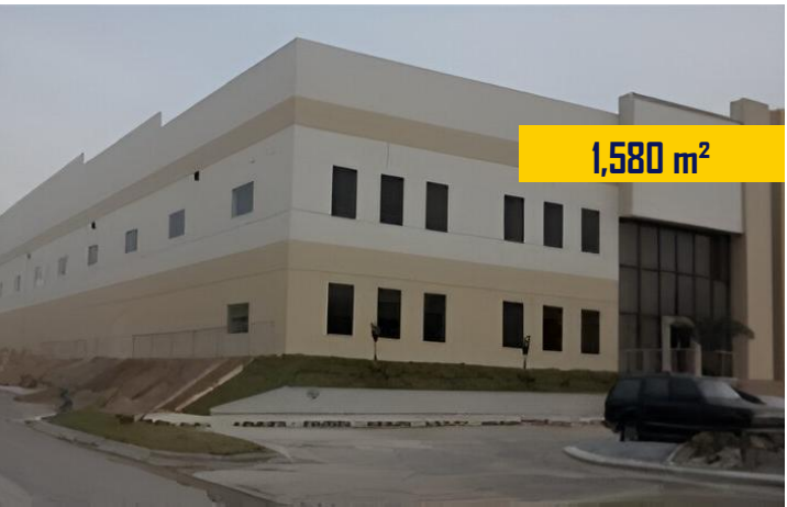
Nave INVENTARIO G-14 Muros Prefabricados ▼ Guadalupe N. L.
