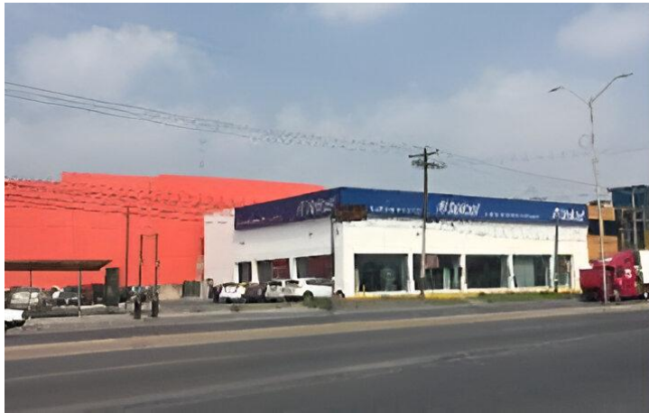
C.A.C TELCEL Muros Prefabricados ▼ Nogales, Sonora, Oregón, Sonora, Hermosillo, Sonora Y Mazatlán, Sinaloa
