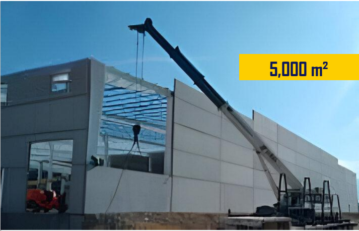
Nave abs. | Absormex Muros Prefabricados ▼ El Carmen N. L.
