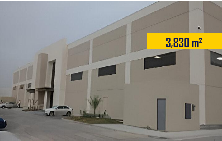
Nave INVENTARIO G-15 Muros Prefabricados ▼ Guadalupe N. L.
