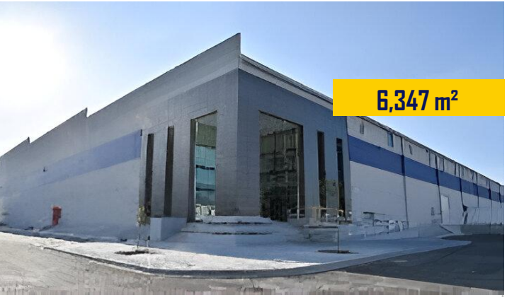
Nave Carrier Muros Prefabricados ▼ Santa Catarina N.L.
