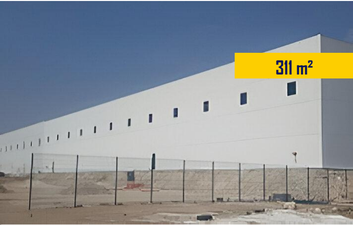
Nave SPM Muros Prefabricados ▼ Reynosa, Tamps.
