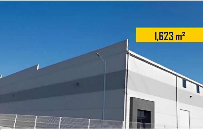
Nave Ampliación Santa Catarina ▼ Santa Catarina N. L.
