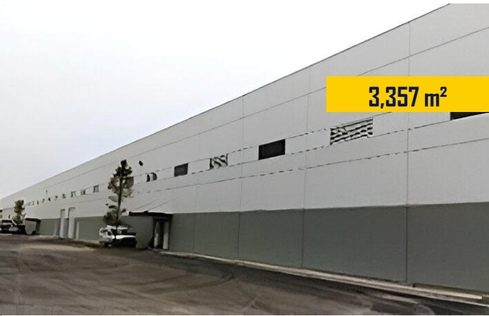
Nave EL SABINAL I Muros Prefabricados ▼ Apodaca N. L.
