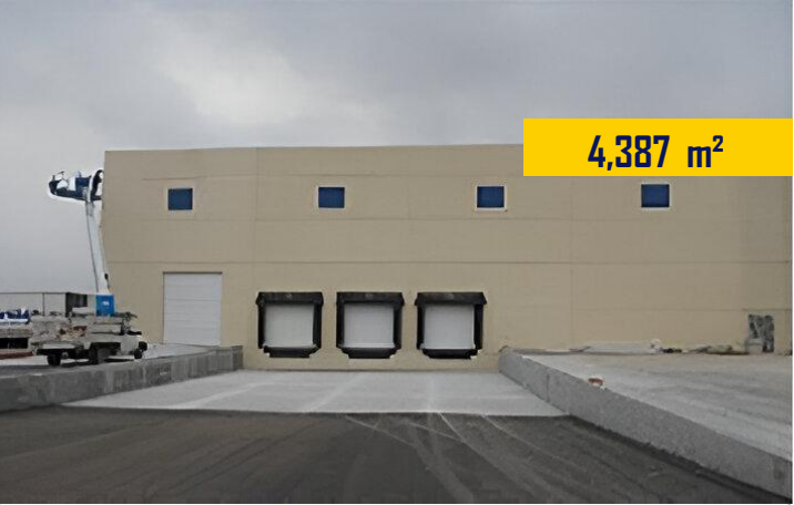
Nave DANHILL IV Muros Prefabricados ▼ Apodaca N. L.
