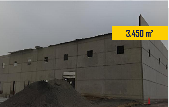
Nave GBOX Muros Prefabricados ▼ Apodaca N. L.
