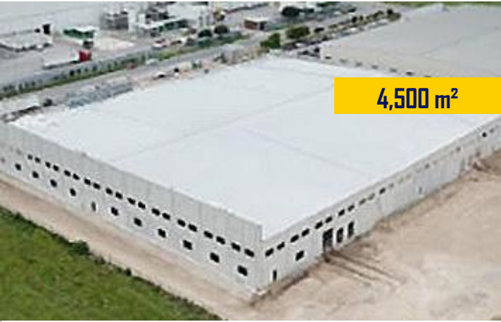
Nave NAVE RE-02 Muros Prefabricados ▼ Reynosa Tamaulipas
