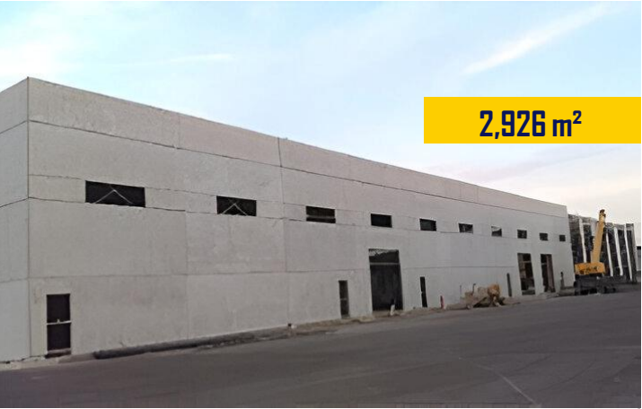
Nave EL SABINAL 3 Muros Prefabricados ▼ Apodaca N. L.
