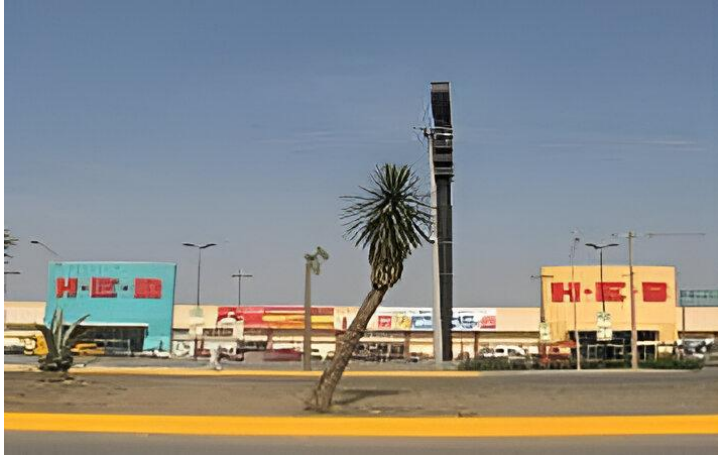
H.E.B Muros con acabado aparente ▼ Reynosa, Tamps., Torreón Coah. Monterrey N.L.
