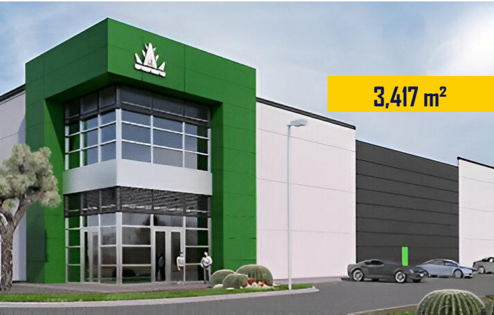
Nave CACTUS II Muros Prefabricados ▼ Ramos Arizpe, Coah.
