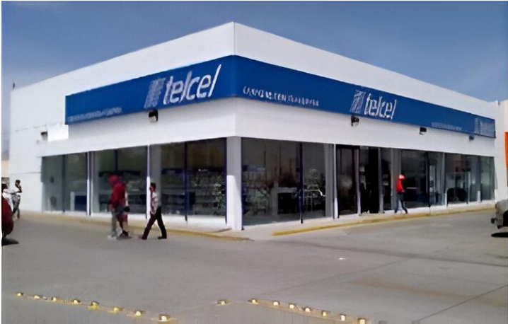
C.A.C TELCEL NORESTE Muros Prefabricados ▼ Frontera, Coah. Saltillo, Coah. C.D. Mante, Coah. Y Guadalupe, N.L.
