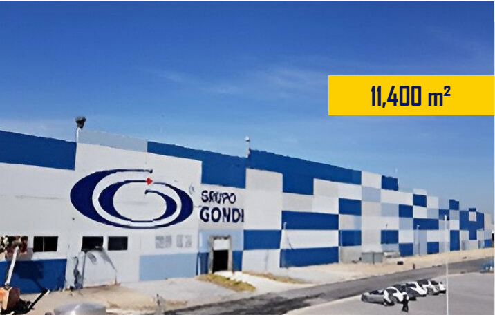
Nave GONDI Muros Prefabricados ▼ Guadalupe N. L.
