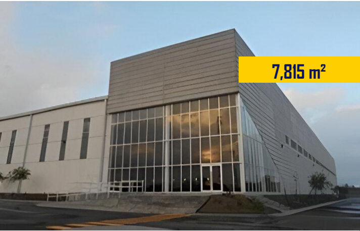
Nave TREDEC III Muros Prefabricados ▼ Ciénega De Flores, N.L.
