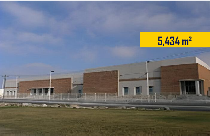
Nave NAVE DWH2 Muros Prefabricados ▼ Apodaca N. L.
