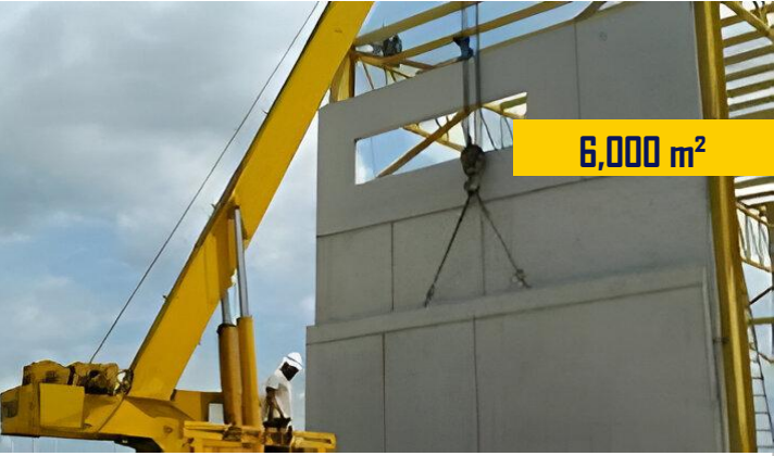
Nave Muros Precolados Libramiento ▼ Cadereyta N.L.
