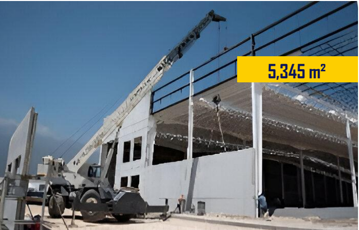
Nave Muros prefabricados bodega Mo-07 ▼ García N.L.
