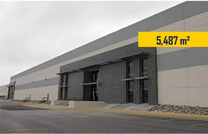
Nave AEROPUERTO I Muros Prefabricados ▼ Apodaca N. L.
