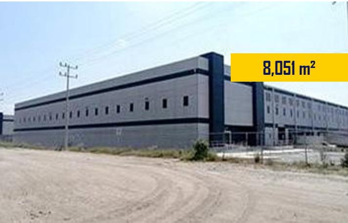
Nave ATP B-018 Muros Prefabricados ▼ Apodaca N. L.
