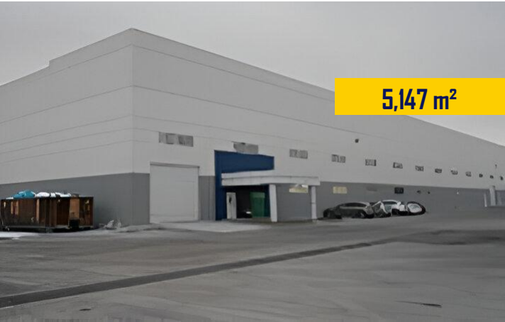
Nave SABINAL II Muros Prefabricados ▼ Apodaca N. L.
