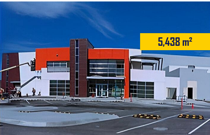
Nave FAPSA Muros Prefabricados ▼ Ciénega De Flores, N.L.
