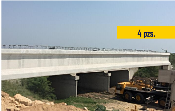
PUENTE LA GARITA Trabe Tipo Nebraska De 37 M y Long ▼ 10+ 380.20
