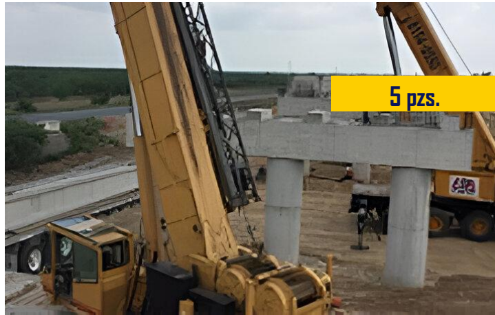
PUENTE LA GLORIA Montaje De Trabe Tipo Aastho ▼ Nuevo Laredo, Tamaulipas
