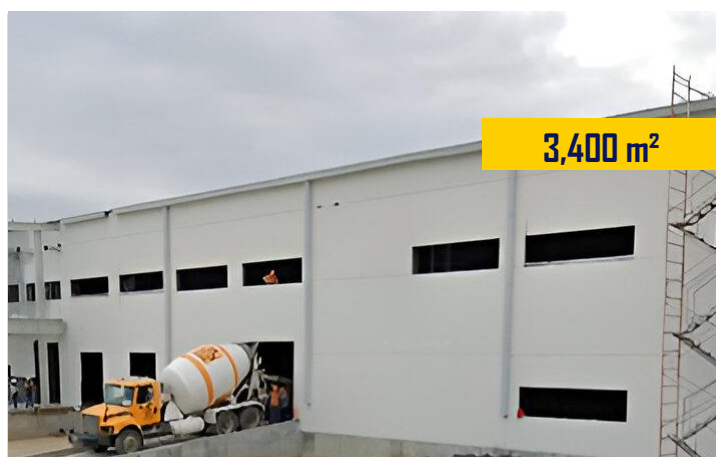
Nave HAENG SUNG Muros Prefabricados ▼ Apodaca N. L.
