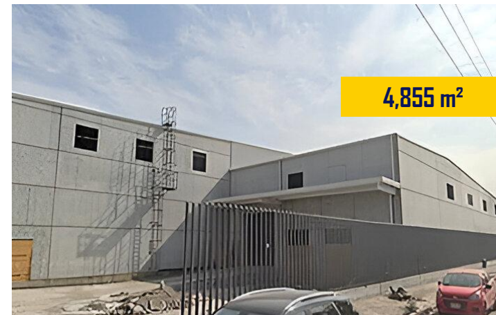
Nave BARNES Muros Prefabricados ▼ Monterrey N. L.
