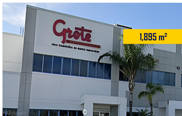
Nave GROTE Muros Prefabricados ▼ Apodaca N. L.
