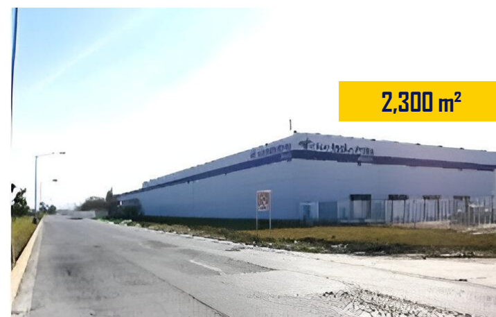
Nave ICE INDUSTRIES Muros Prefabricados ▼ Apodaca N. L.
