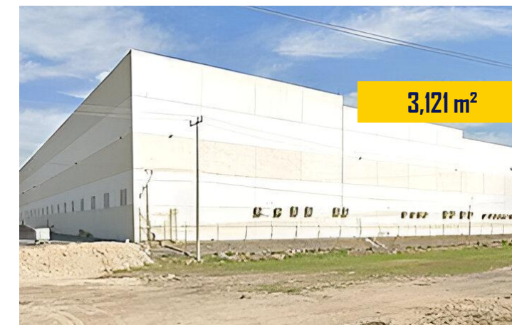
Nave HALD Muros Prefabricados ▼ Apodaca N. L.
